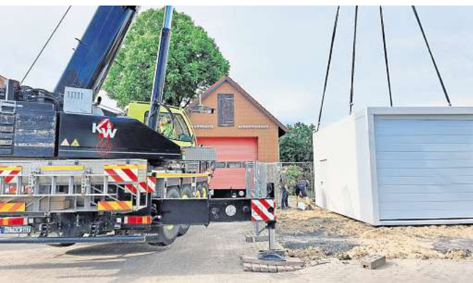
Ein Autokran hebt die neue Fertiggarage der Ortsfeuerwehr Kirchwehren an ihren vorgesehenen Standort. Die knapp sieben Meter lange, rund 3,80 Meter breite und 3,40 Meter hohe Garage bietet den dringend benötigten Platz für das Mannschaftstransportfahrzeug. Foto: Stadt Seelze
