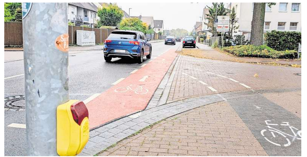
Signalwirkung: Die neu aufgebrachten roten Schutzstreifen an der Roten Reihe an der Einmündung Stephanusstraße sollen für mehr Sicherheit für Radfahrende sorgen. Foto: Jutta Grätz
