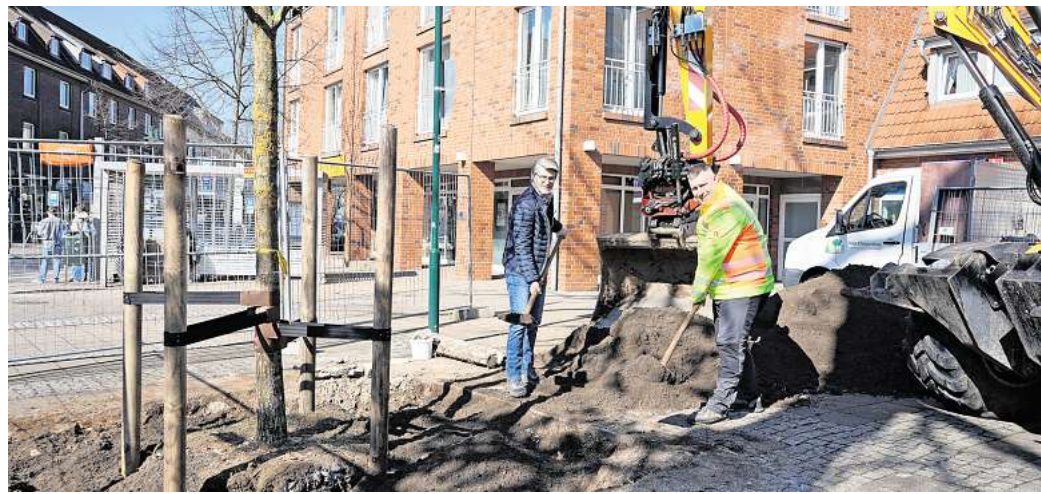
Ein neuer Baum für den Alten Krug: Bürgermeister Alexander Masthoff (links) und Richard Preece von der städtischen Abteilung Mobilität & Entwässerung versorgen die frisch eingesetzte junge Eiche mit sogenanntem Baumsustrat. Foto: Stadt Seelze
