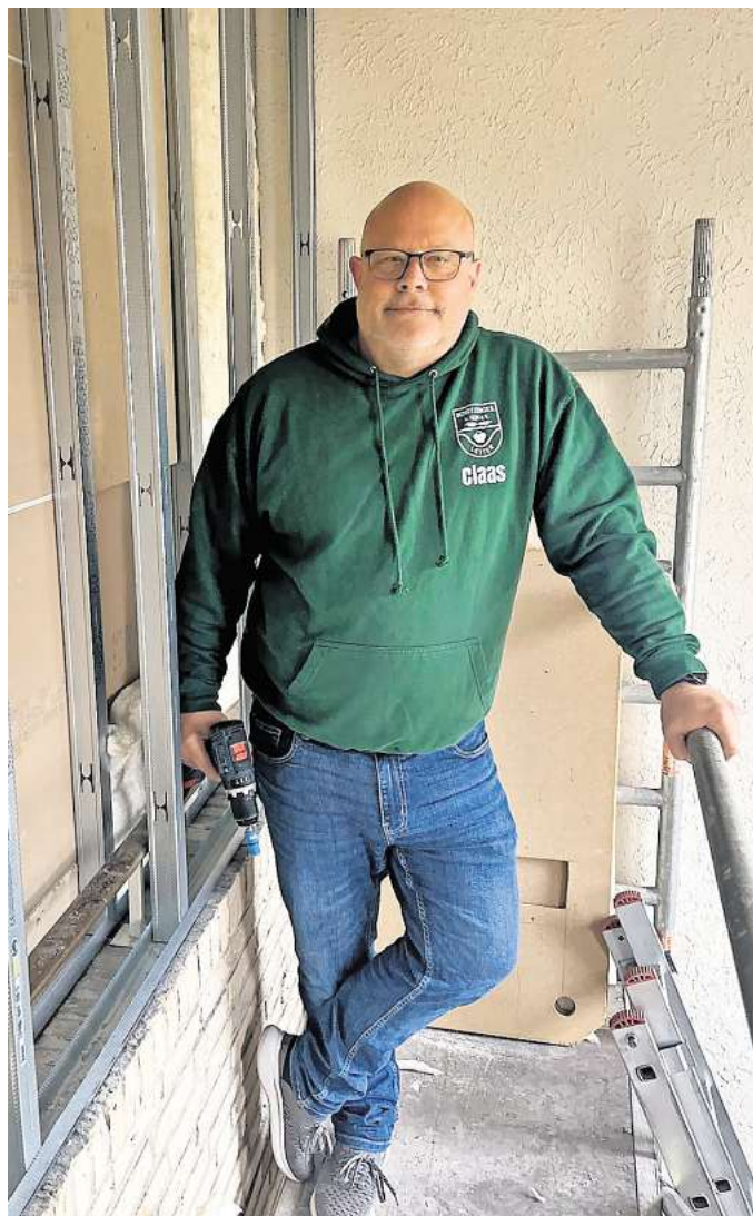
Der Vorsitzende Claas Harmen packt beim Bau einer Trockenwand im Schützenhaus mit an. Foto: Mark Bode
