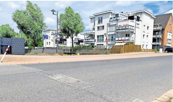
Für mehr Verkehrssicherheit: Die Stadt Seelze lässt während der Sommerferien an den Standorten der bereits zurückgebauten Bremsschwellen in der Straße An den Grachten neue geteilte Plateaupflasterungen einbauen. Foto: Stadt Seelze
