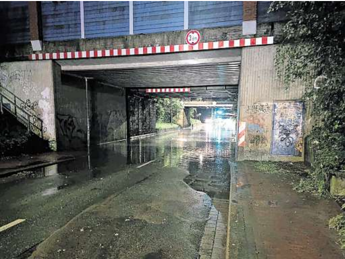
Auch die Eisenbahnbrücke an der Klöcknerstraße war überflutet. Foto: Feuerwehr Seelze
