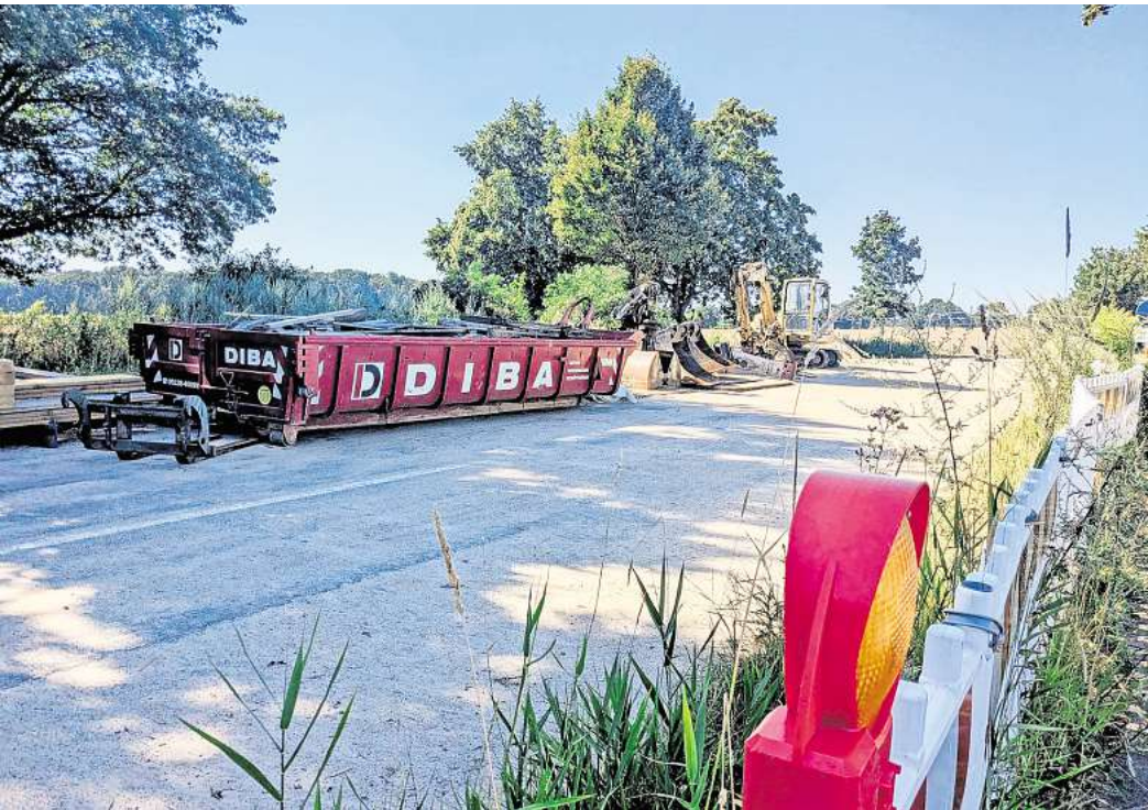
Baufortschritt nach elf Monaten: So sieht die Baustelle an der K322 in Garbsen in Höhe des Horster Bruchgrabens Ende Juli 2026 aus. Foto: Jutta Grätz
