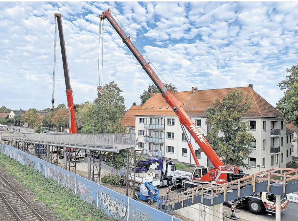
Sichtbarer Fortschritt an der Heimstättenbrücke: Autokräne heben die drei großen Bauteile der neuen Fuß- und Radwegrampe ein. Bis zur Freigabe sind unter anderem noch Arbeiten am Belag und an der Beleuchtung erforderlich. Foto: Stadt Seelze
