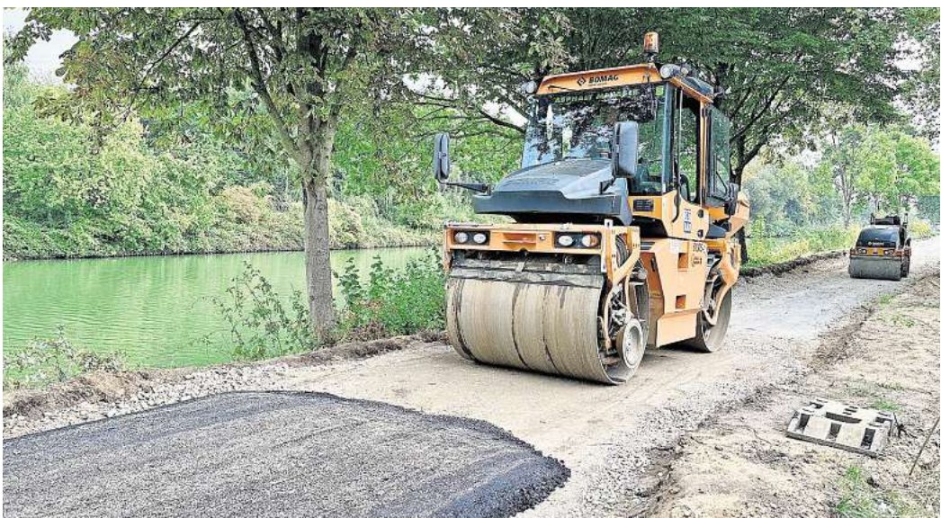
Fahrradfreundlicher Ausbau: Eine Walze verdichtet die neu eingebaute Asphalttragschicht auf dem Betriebsweg am Stichkanal zwischen dem DVS-Bunker und der Kleingartenanlage Hortense. Foto: Stadt Seelze
