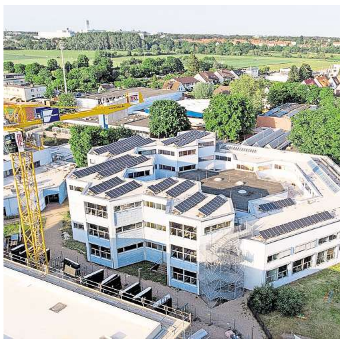
Der Südflügel des Georg-Büchner-Gymnasiums (Bildmitte) hat ausgedient. Mit dem Abriss entsteht Platz für den zweiten Teil des Neubaus mit zusätzlichen Klassen- und Fachräumen sowie modernen Lern- und Aufenthaltsbereichen.
