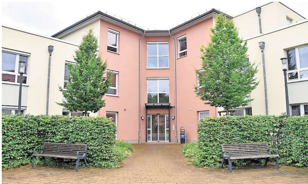
Hier sind Geflüchtete eingezogen: Das Stadtteilhaus in Altgarbsen.
