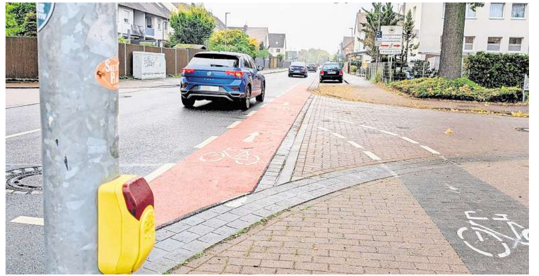
Signalwirkung: Die neu aufgebrachten roten Schutzstreifen an der Roten Reihe an der Einmündung Stephanusstraße sollen für mehr Sicherheit für Radfahrende sorgen. Foto: Jutta Grätz
