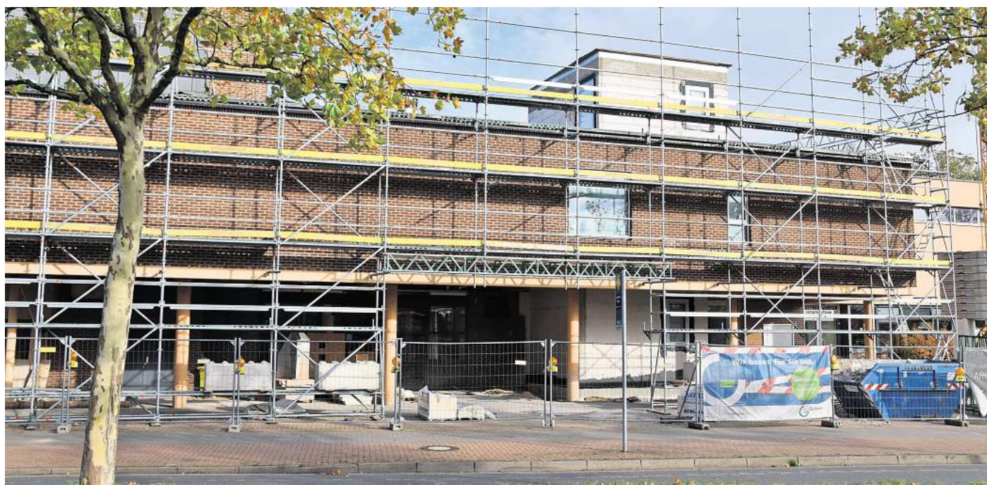
Eingerüstet: Der Rohbau am Hallenbad am Planetenring ist schon fast fertig.
