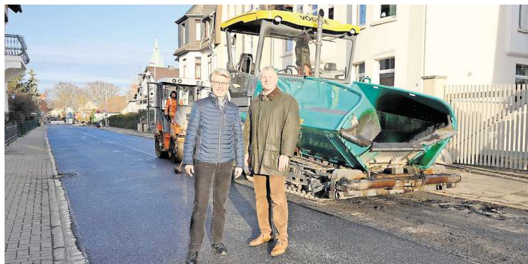
Auftakt eines umfangreichen Straßensanierungsprogramms: Beschäftigte eines von der Stadt Seelze beauftragten Fachbetriebs fräsen die alte Fahrbahndecke der Bonhoefferstraße ab. Foto: Stadt Seelze
