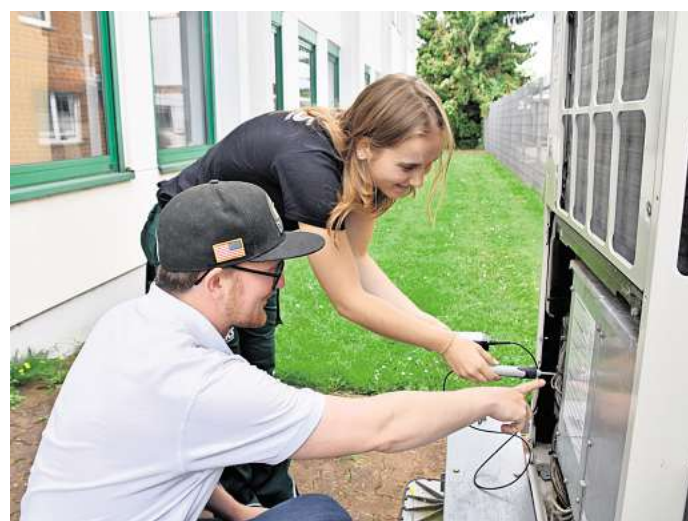
Ausbildung in Garbsen: In der Firma RKS prüft Catalina Buhl mit dem Ausbildungsbeauftragten Niclas Höfler die Außeninheit einer Klimaanlage. Auch dieses Unternehmen ist bei der Berufsmesse vertreten. Foto: Gerko Naumann
