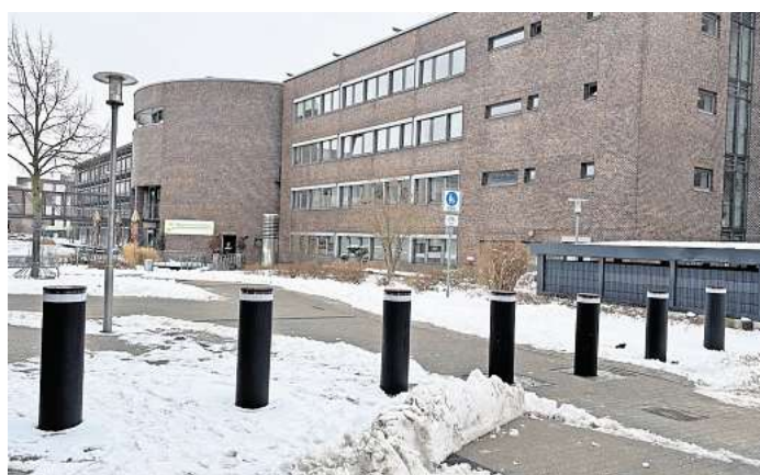
Insgesamt wurden 21 Poller installiert, davon sieben hydraulisch versenkbar. Foto: Stadt Garbsen
