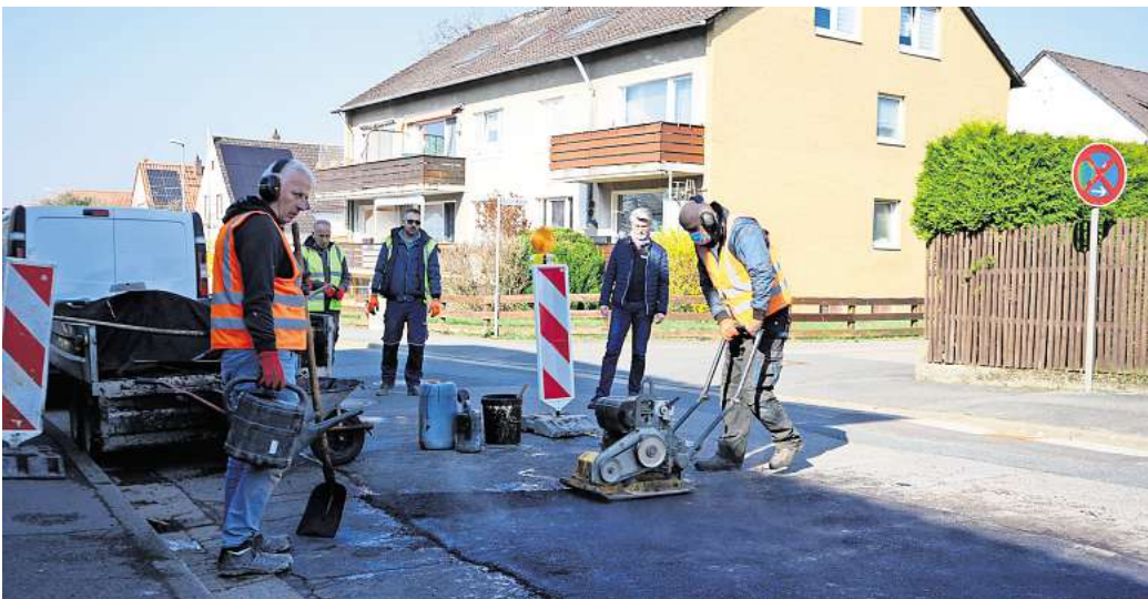
Fachgerechte Reparaturen am Westerwinkel: Beschäftigte der Straßenbaufirma glätten den heißen Asphalt und rütteln ihn ab. Bürgermeister Alexander Masthoff (Mitte) verschafft sich einen Eindruck von den Arbeiten. Nach rund einer Stunde ist die Fahrbahn wieder für den Verkehr freigegeben.
