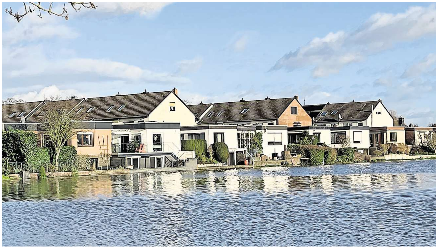
Altgarbsen war extrem betroffen: Anfang 2024 dauerte es Wochen, bis das Hochwasser in der Leinemasch zurückging.
