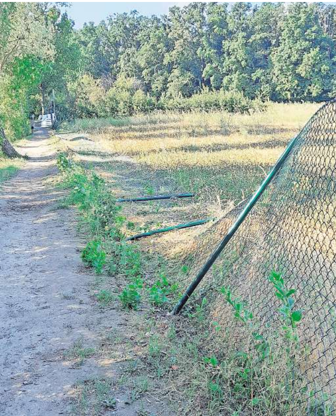
Vandalismus am Lohnder Kiesteich: Unbekannte haben den Maschendrahtzaun an der Westseite des Geländes umgeworfen und fast alle Pfosten verbogen. Die Stadt Seelze schätzt den Schaden auf rund 3000 Euro. Foto: Stadt Seelze
