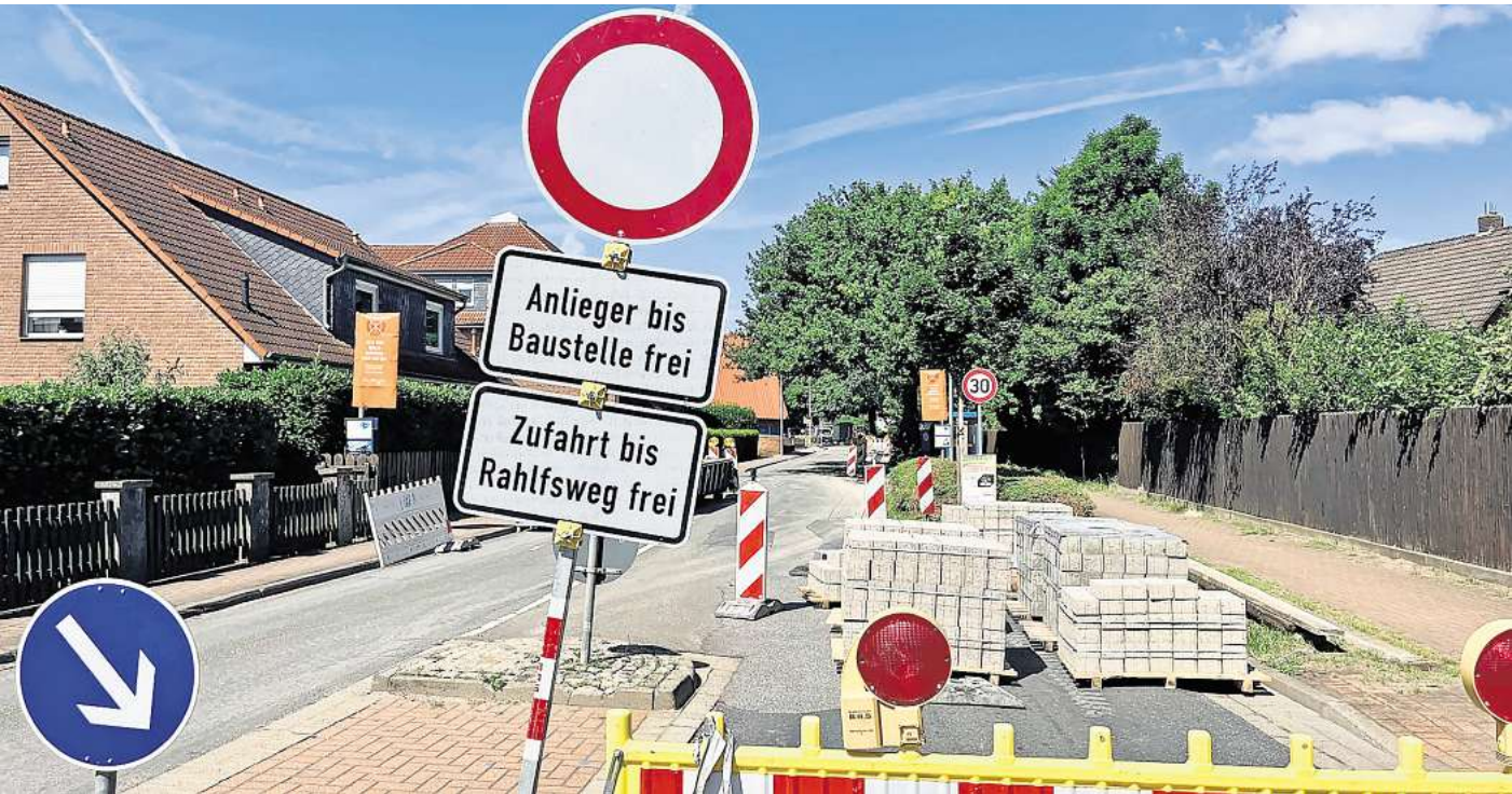
Hier geht es nicht weiter: Die Dorfstraße in Berenbostel ist wegen Bauarbeiten gesperrt. Das hat vor allem Auswirkungen auf die Verkehrssituation in Stelingen.
