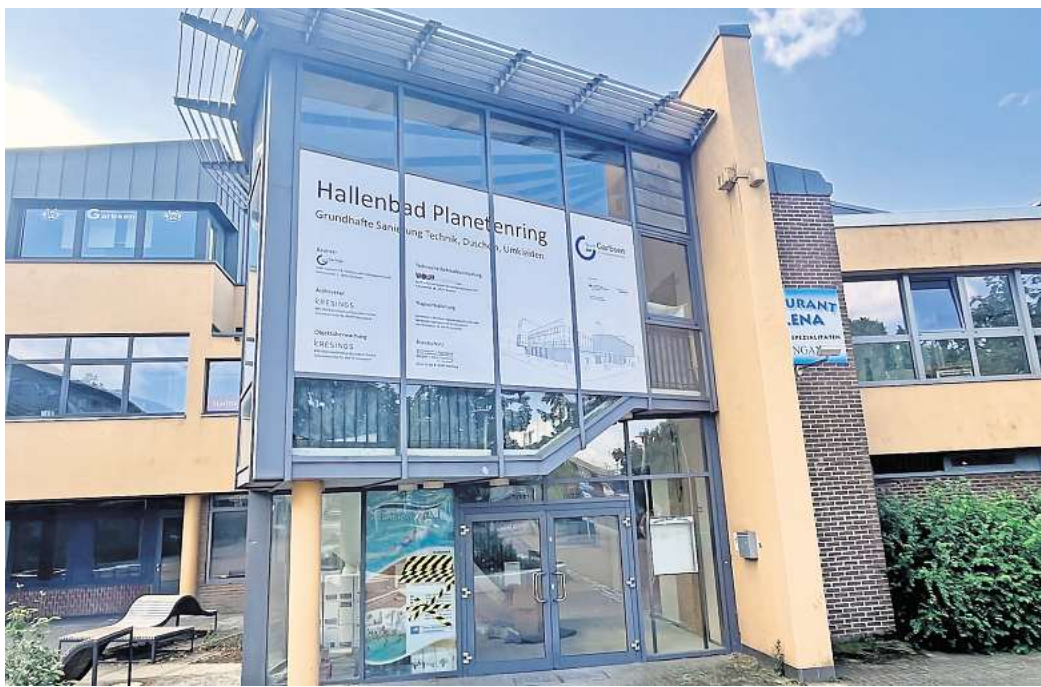
Vorerst geht es hier nicht weiter: Die Sanierung im Planetenbad pausiert, nachdem erhebliche Mängel bei den Bodenarbeiten in dem Schwimmbad festgestellt wurden. Foto: Julia Braun
