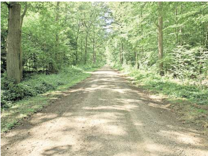
Mit den abgeschlossenen Arbeiten sind die Wege im Haster Wald wieder für die kommenden Jahre gut nutzbar. Foto: Sören Petschäls NLF
