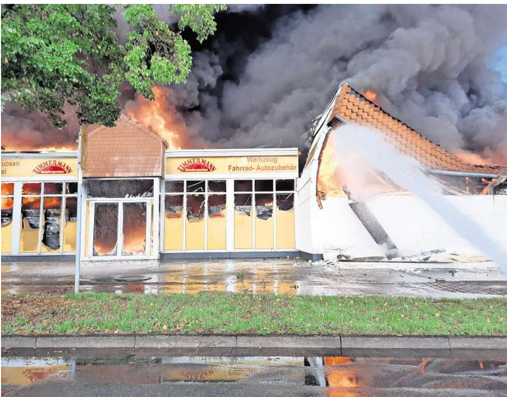
Nachdem ein Brand im Zimmermann-Sonderpostenmarkt ausbrach, stürzte das Dach ein. Fotos: Feuerwehr Seelze
