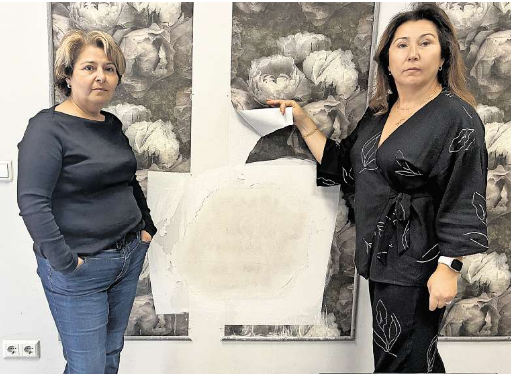
Noch immer fassungslos: Die Schwestern Ülkü (links) und Gülhan Kahraman stehen vor der Wand in ihrem Friseursalon, in die die Einbrecher die zwei Löcher geschlagen haben. Diese sind mittlerweile wieder verfüllt. Foto: Mirko Haendel
